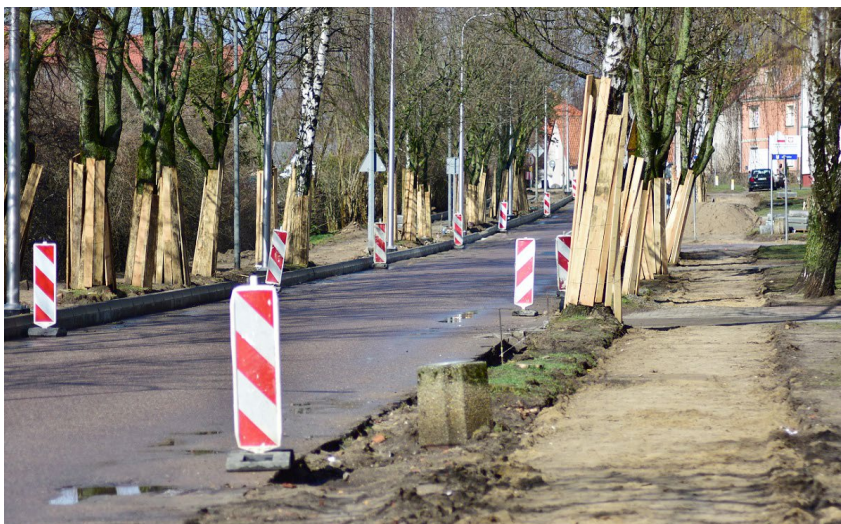
Rozpoczął się remont ulicy Sikorskiego. Za kilka miesięcy oczy mieszkańców cieszyć będzie nowa jezdnia, chodniki i oświetlenie. Podobnie będzie na sąsiedniej ulicy 3 Maja
